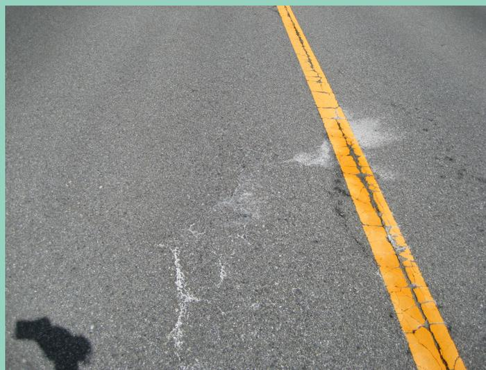
クラックにより水が浸入し、分離したセメント質が溶け出している。床版土砂化の初期症状。
