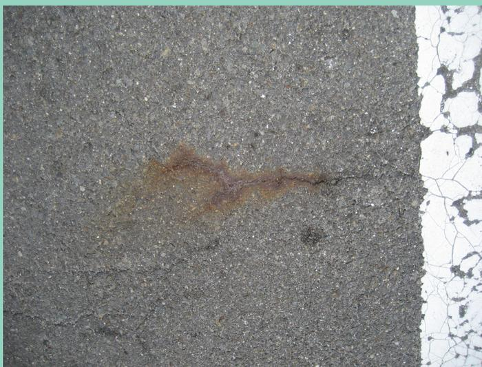
床版内部の鉄筋腐食により錆汁が噴出している。クラックが床版鉄筋まで到達していると想定される。
