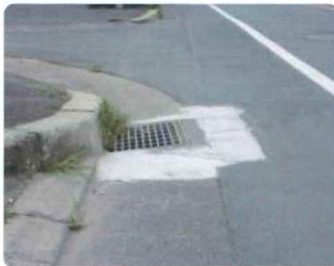
■ 集水桝復旧補修
