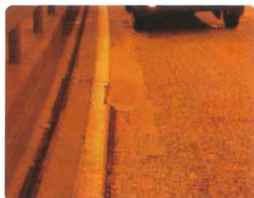
■ 賤母トンネル内コンクリート舗装補修
