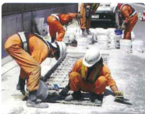
■ 中央自動車道松本管内維持修繕
