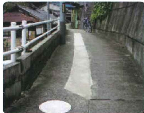
■ 歩道部段差補修
