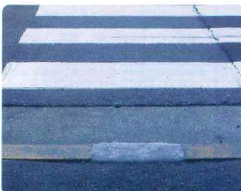
■ 歩車道ブロック補修
